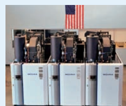
米国で活躍する低NO x 対応蒸気ボイラLX-300(4.5t/h)×3基
