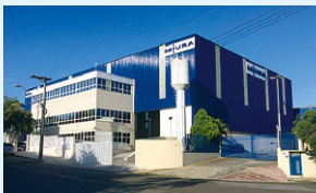
MIURA BOILER DO BRASIL LTDA.
