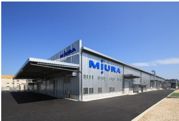
▲多目的工場完成写真
