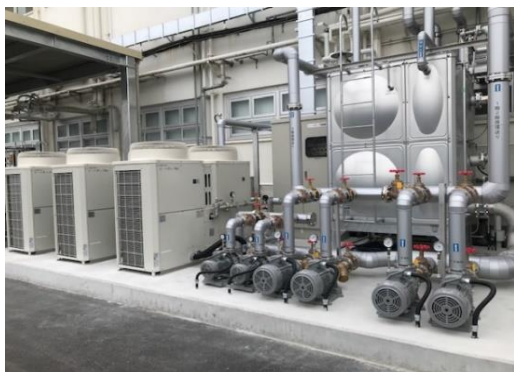
ヒートポンプ
