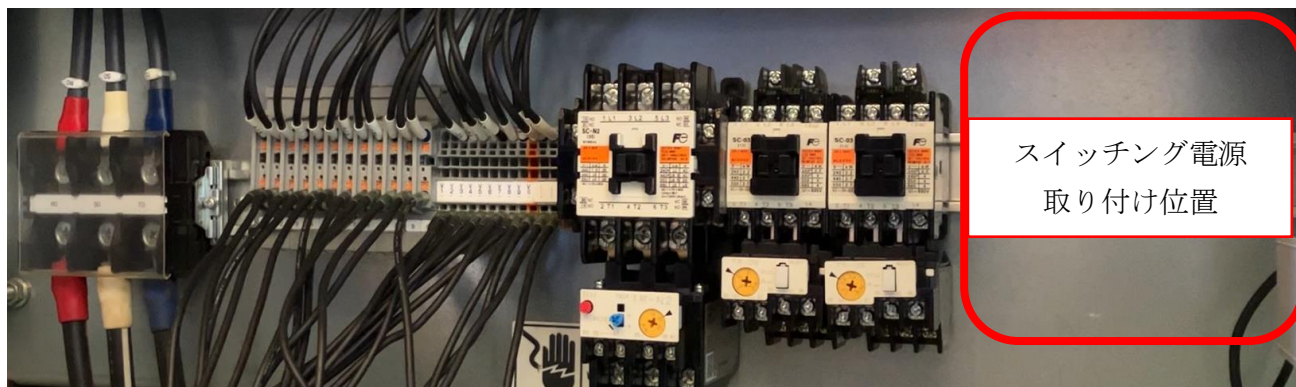
図 19 端子台、開閉器取り付け後
