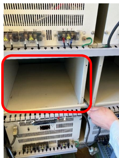
図 8 4kW 電源引き抜き後の空間
