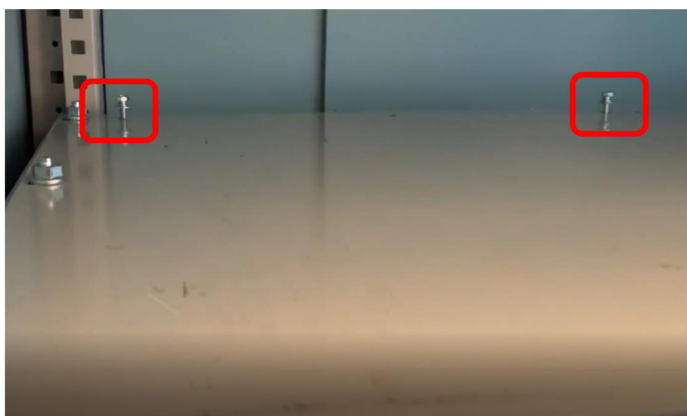
図 11 電源盤棚板 ワッシャ付きボルト取り付け後
