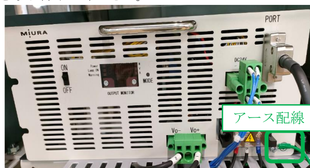
図 28 8kW 電源 正面配線(アース配線)取り付け箇所
