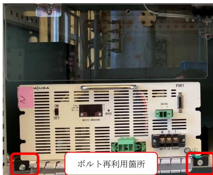
図 13 8kW 電源交換キット(2 灯式 6 個入れ電源盤)固定位置
