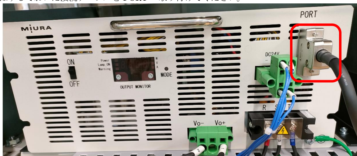
図 31 8kW 電源接続ケーブル取付
