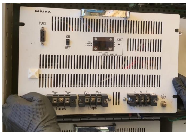
図 5 4kW 電源取り外し
