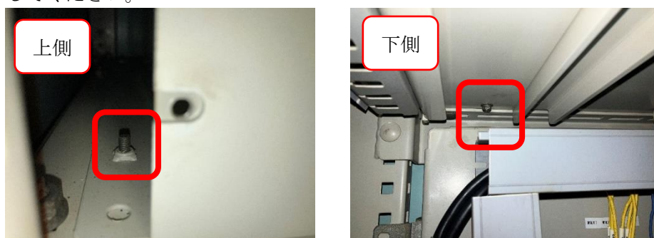
図 7 ボルト取付の場合
