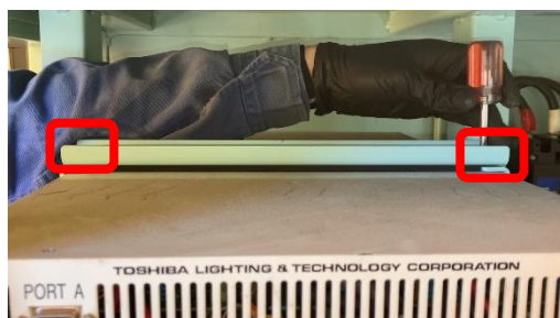
図 5 UV 電源押さえ板 固定ネジ取り外し
