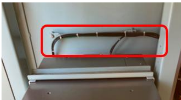
図 3 1 灯 レール式 4kW 電源盤側配線取り外し箇所
